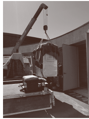
搬入作業の様子
