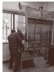
ドラフト装置の設置
